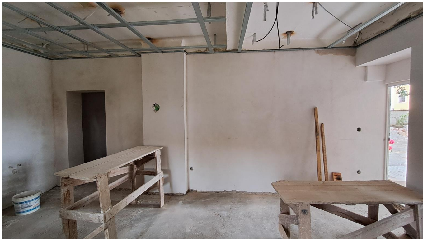
Foto č. 6 – Klubovna v budově OÚ – nové omítky a bet. podlaha, realizace podhledu (05.08.24)
