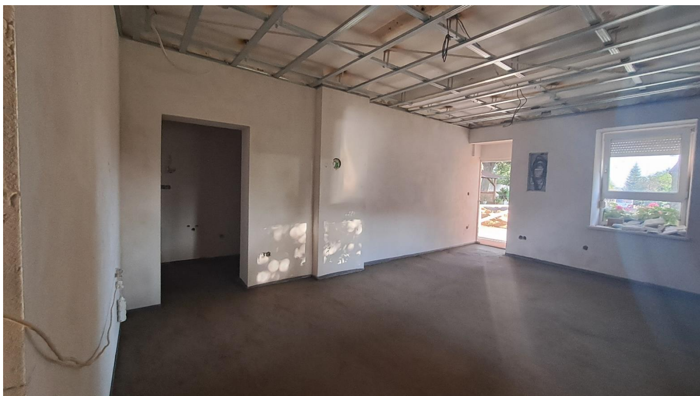
Foto č. 9 – Klubovna v budově OÚ – betonová podlaha pod dlažbu (07.08.24)
