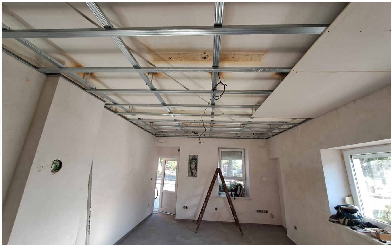
Foto č. 10 – Klubovna v budově OÚ – dlažba, montáž podhledu (13.08.24)
