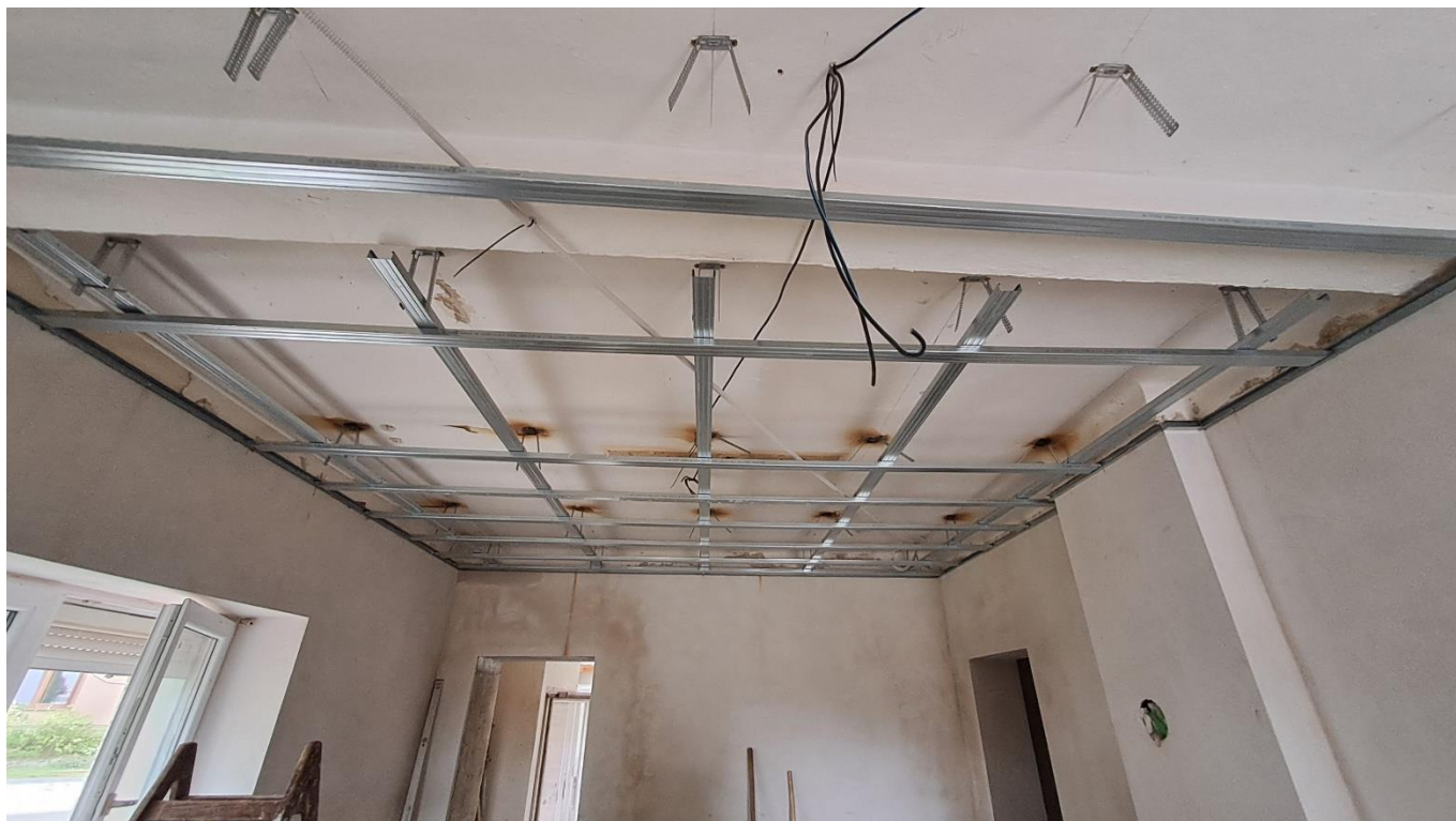
Foto č. 7 – Klubovna v budově OÚ – nové omítky, realizace podhledu – rastr (05.08.24)
