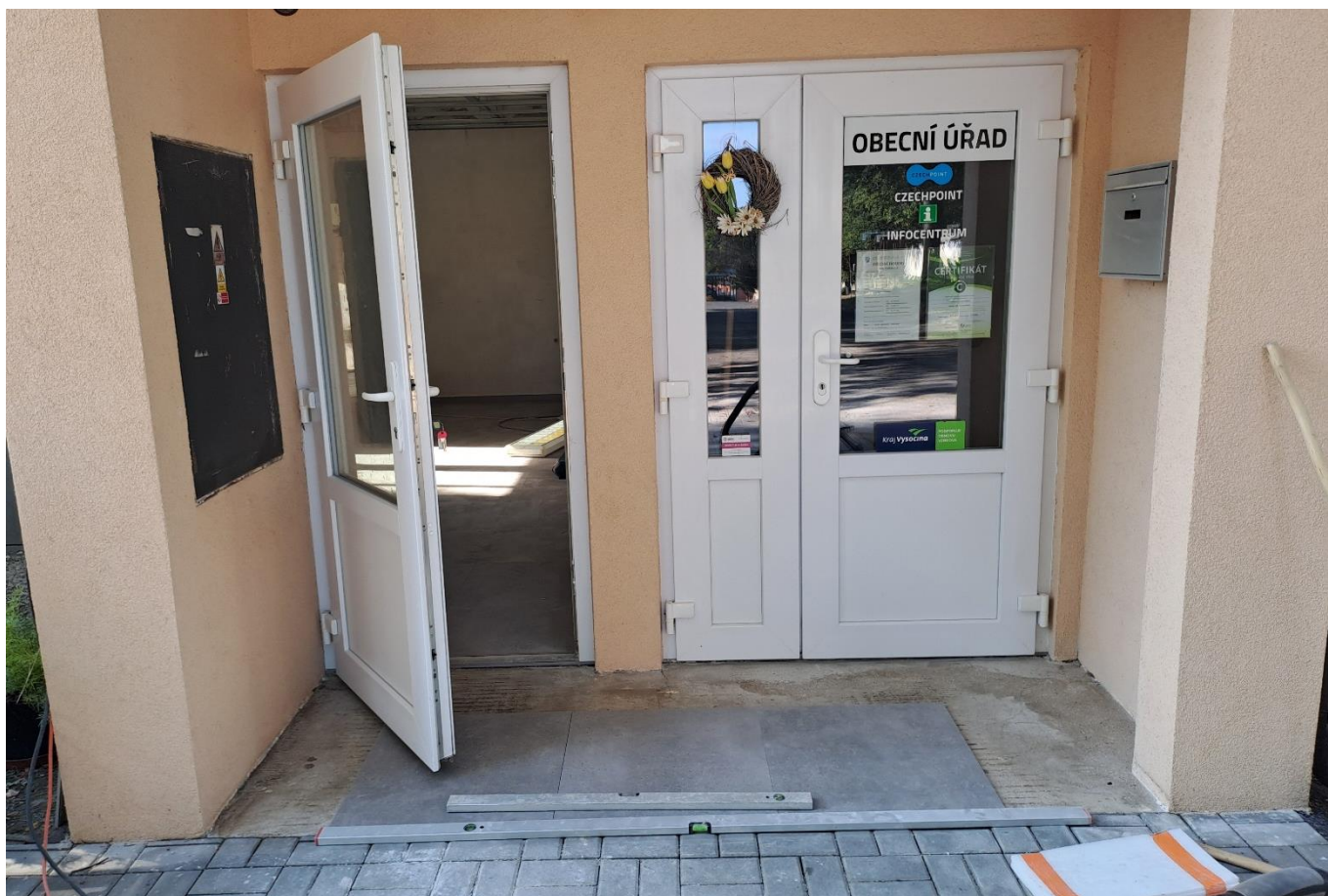
Foto č. 11 – Klubovna v budově OÚ – dlažba před vstupem (13.08.24)
