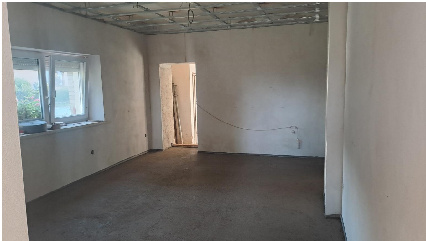
Foto č. 8 – Klubovna v budově OÚ – betonová podlaha pod dlažbu (07.08.24)
