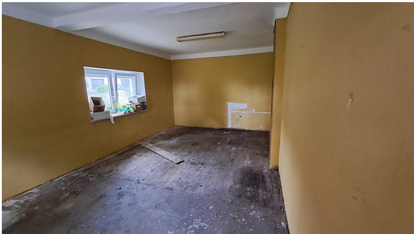
Foto č. 2 – Klubovna v budově OÚ – úklid před realizací (21.05.24)
