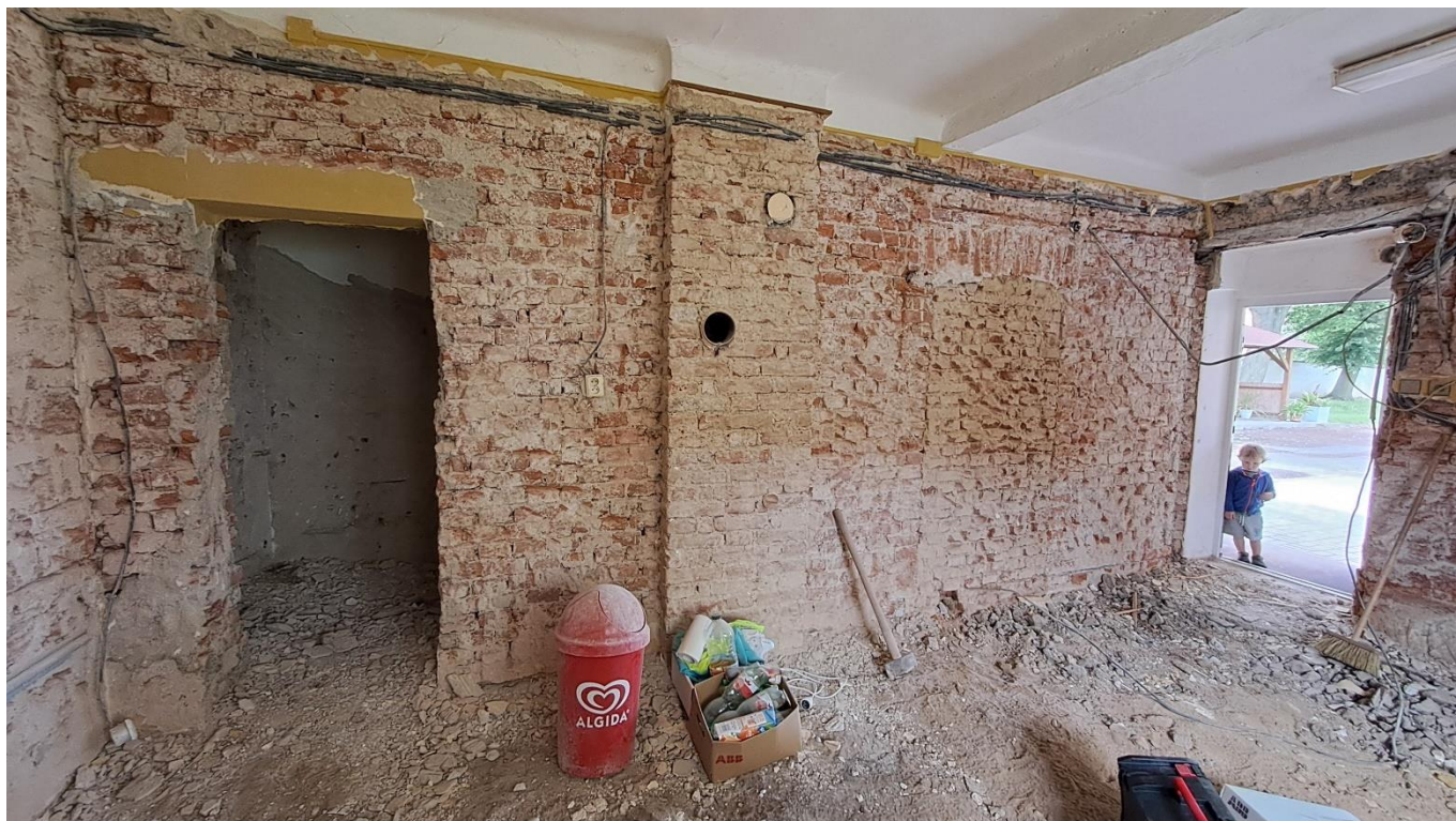
Foto č. 5 – Klubovna v budově OÚ – vybouraná podlaha a oklepání omítky (25.05.24)
