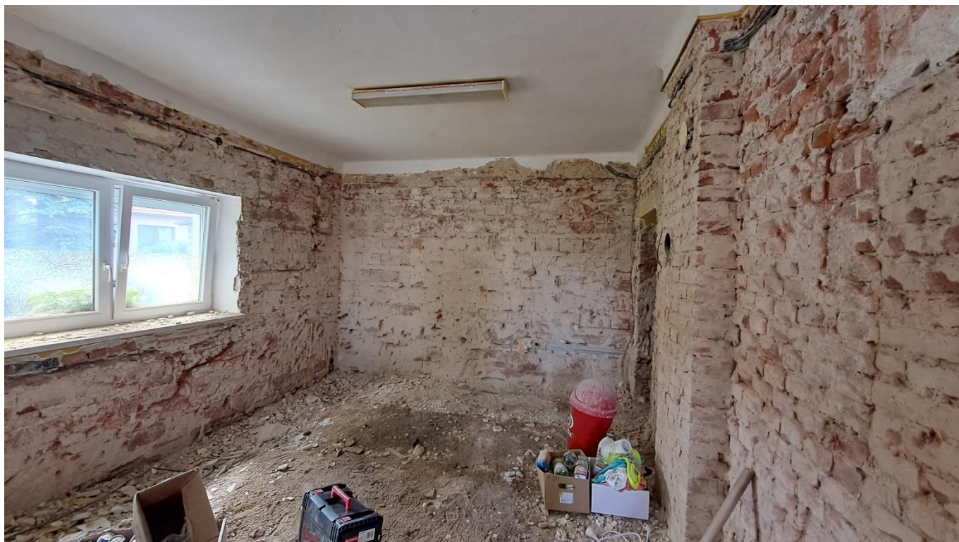
Foto č. 4 – Klubovna v budově OÚ – vybouraná podlaha a oklepání omítky (25.05.24)
