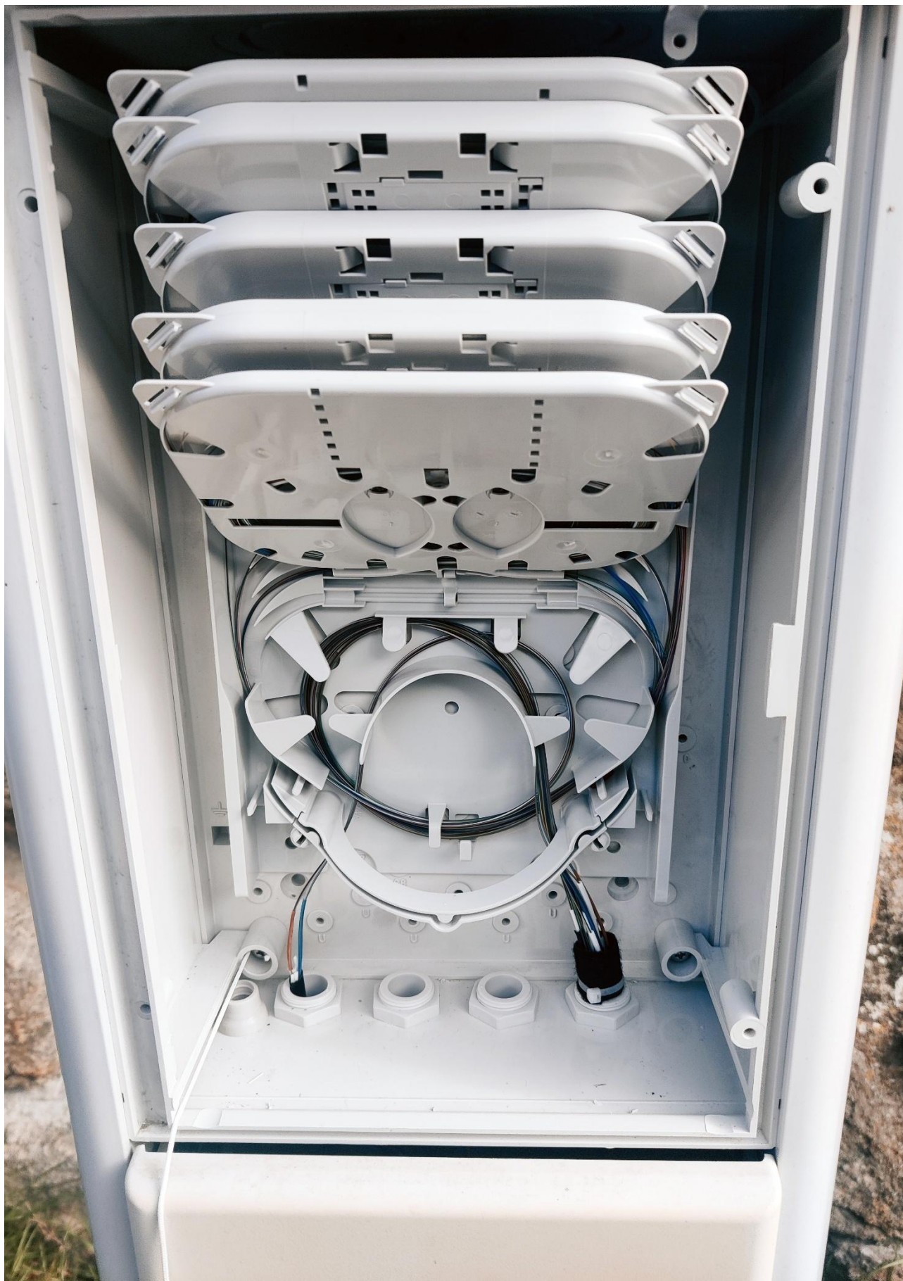
Foto č. 10 – sloupek u RD č.p. 47 – uspořádání kazet ve sloupku SB 2.2-F
