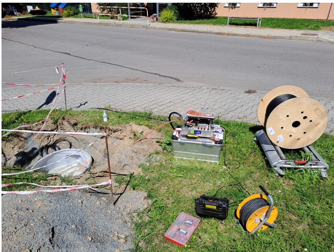
Foto č. 1 – komora před školou – realizace záfuku optického vlákna
