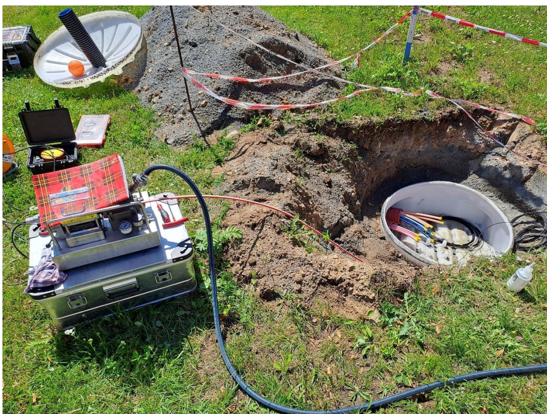
Foto č. 2 – komora před školou – realizace záfuku optického vlákna
