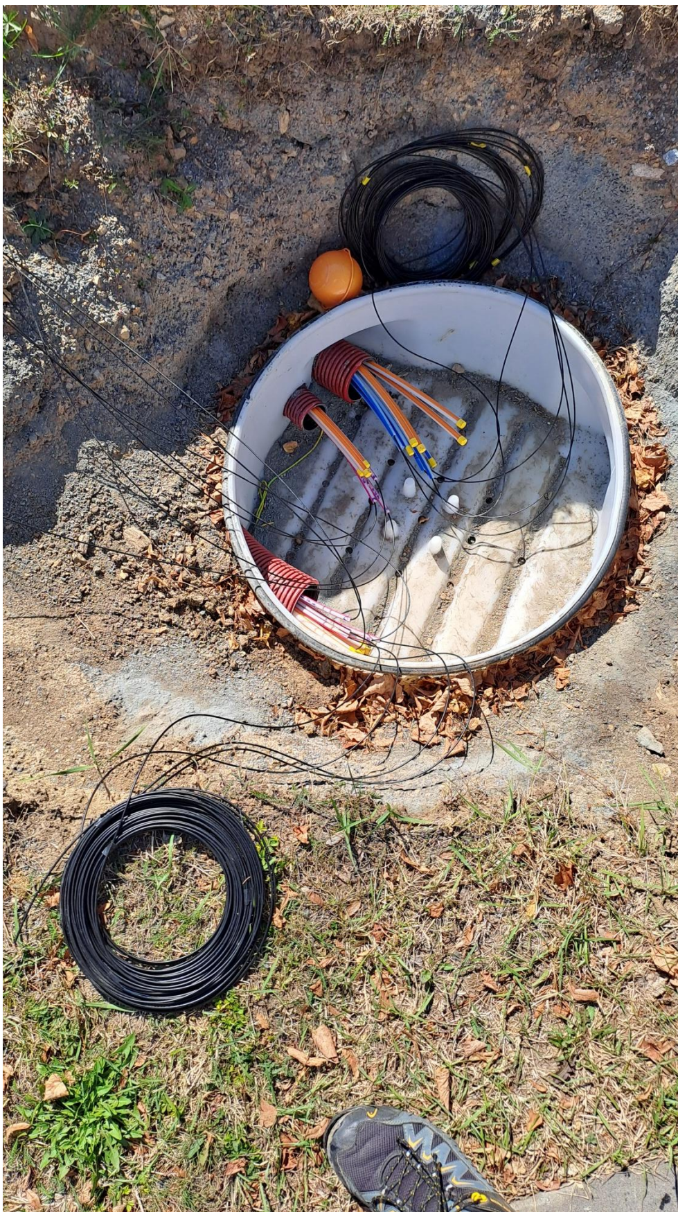
Foto č. 3 – komora v mlýnské ulici před RD č.p. 127
