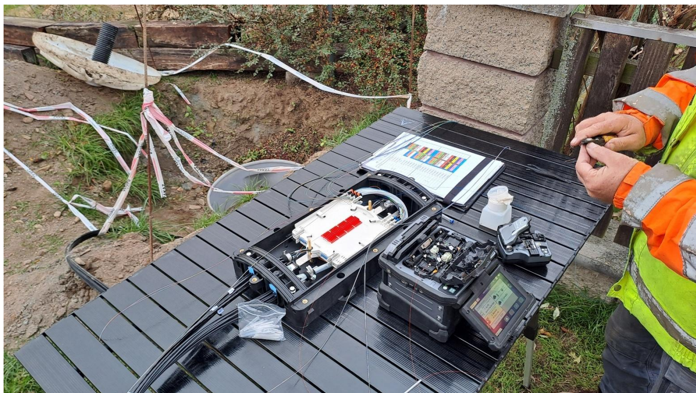
Foto č. 5 – komora v mlýnské ulici před RD č.p. 127 – svařování optického vlákna
