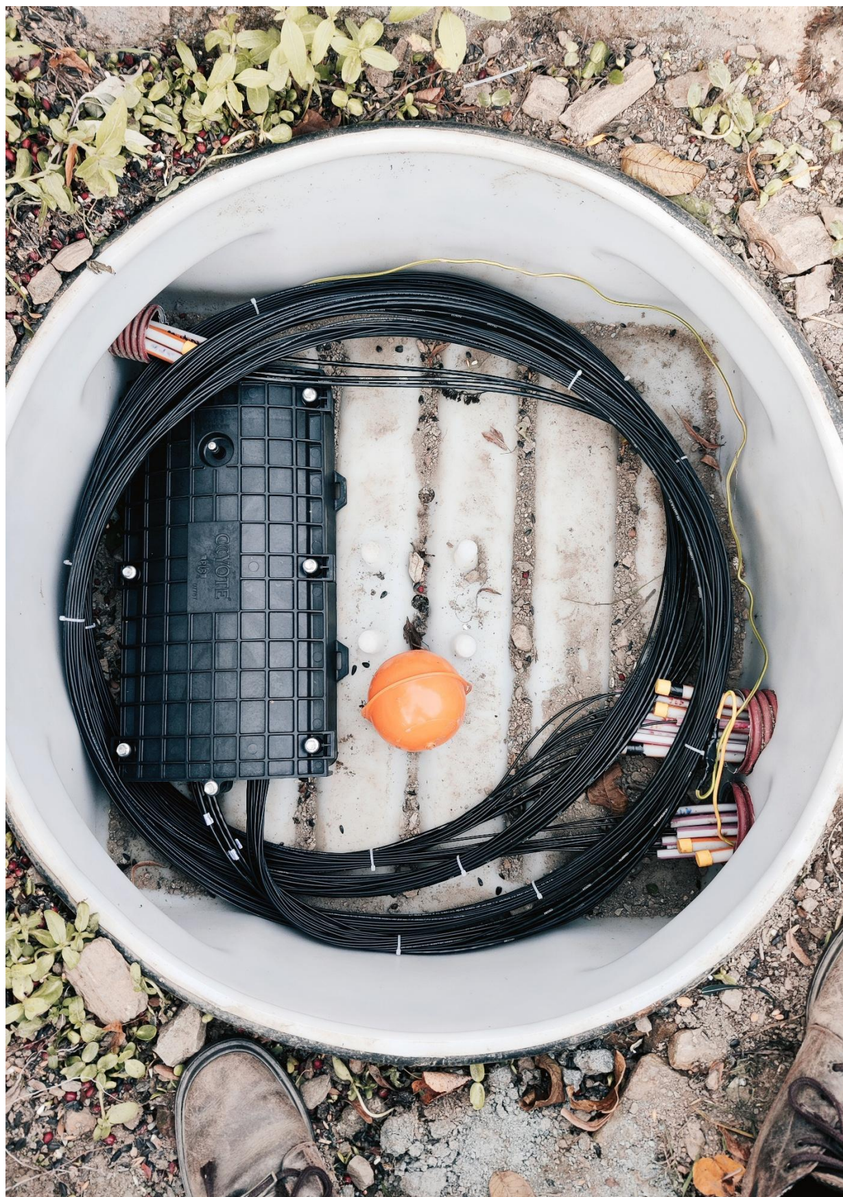
Foto č. 8 – uspořádání v komoře KK1.3
